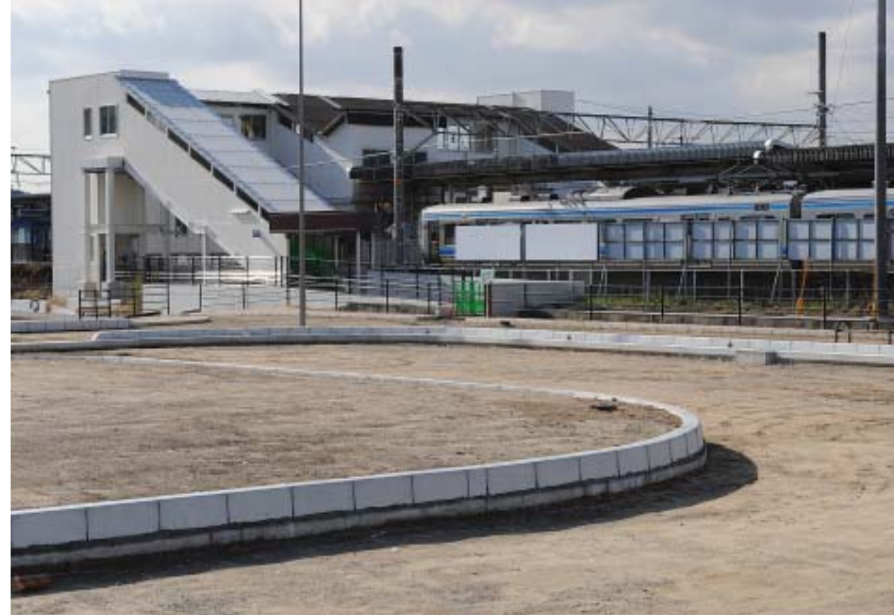
工事中の清音駅東側のロータリー(昨年12月撮影)。写真左奥の建物には、駅の東西を自由に行き来できる通路とエレベーターがある。エレベーターは3基あり、通路の東西と、岡山方面行きホーム(井原線ホームへの連絡)に整備された。ロータリーや交流広場などの植栽は3月末までに行われる
