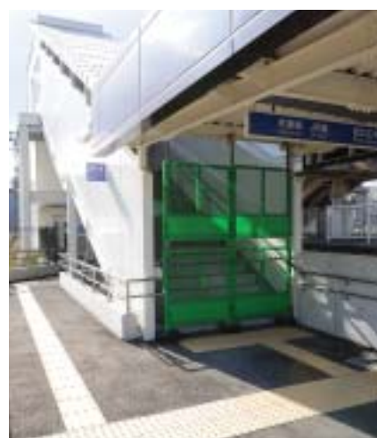
清音駅の東西を結ぶ通路の東側階段。写真左奥がエレベーター
