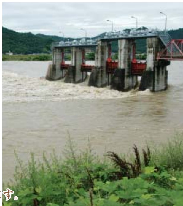
増水した高梁川（平成18年7月）
