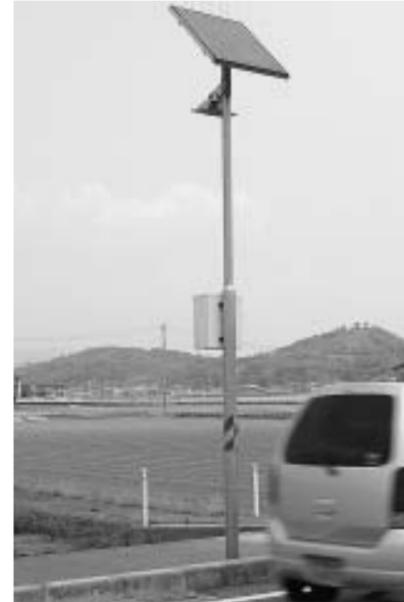
街路灯の高さは約4.2m。ソーラーパネルの出力は98ワットで、LED照明の消費電力は最大20ワット。点灯するのは、日没から日の出まで
