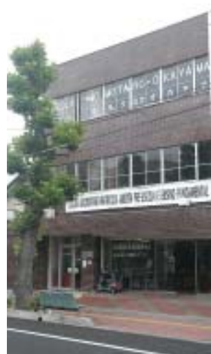
ブラジル人学校は総社駅前の民間ビルで運営。3階部分に教室やトイレ、職員室、保健室などがある
