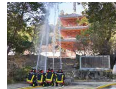
井山宝福寺三重塔へ一斉放水
