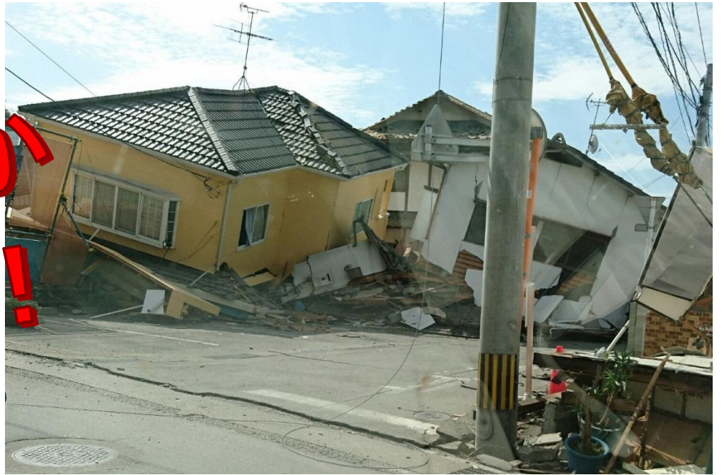
熊本地震（H28年）での住宅の被害状況
