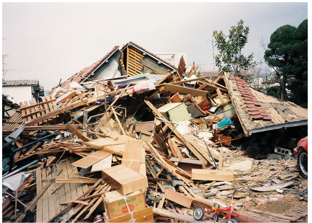
阪神淡路大震災（H7年）での住宅の被害状況
