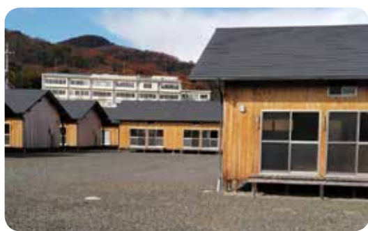
一部が美袋駅前で活用される西仮設住宅
