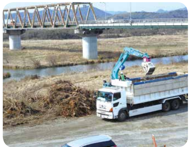
大型重機により伐採作業が進む高梁川(川辺橋付近)
