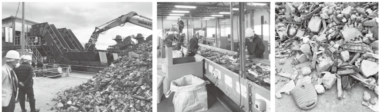
重機が休みなく動き1日300トン进行处理する
