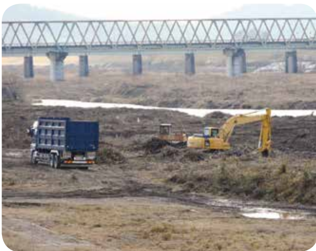
伐採が完了しつつある高梁川(川辺橋付近)
