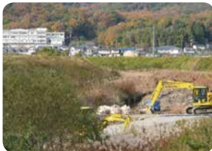
②改修工事が進む新本川(八代地内)
