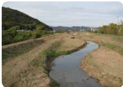
①伐採が完了した新本川(下原地内)
