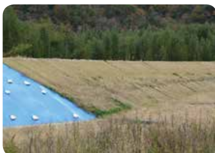
復旧が進む高梁川堤防(下倉地内)
