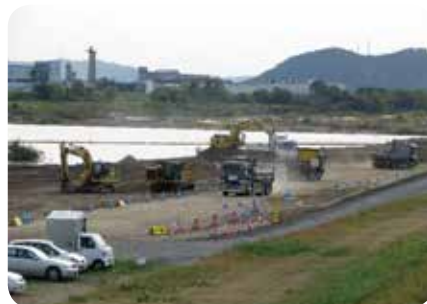
③浚渫(土砂撤去)工事が進む高梁川(秦地内)
