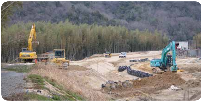
着々と進む昭和地区の堤防復旧工事 下倉(草田地区)
