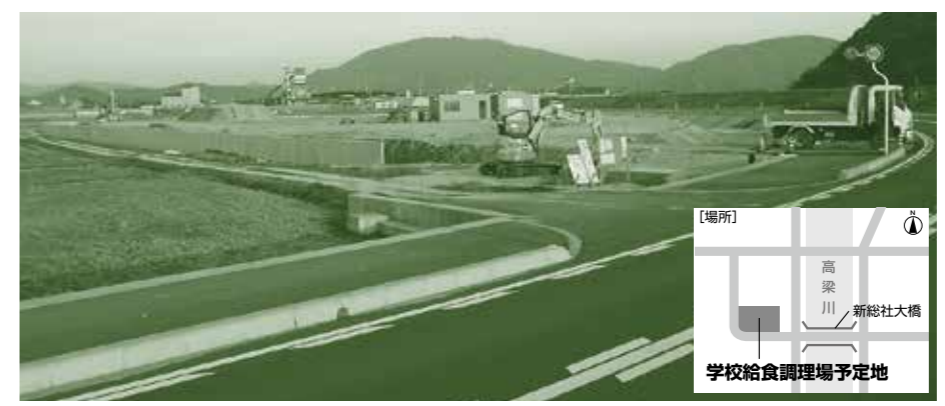
平成31年9月稼働を目指し工事が進む学校給食調理場
