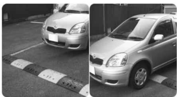
速度減速帯(バンプ)の設置例 段差により衝撃があるため確実な減速が期待できる
