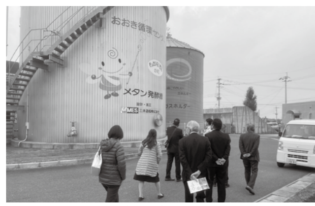
し尿等を発酵させ、バイオガスと有機液肥を回収している
