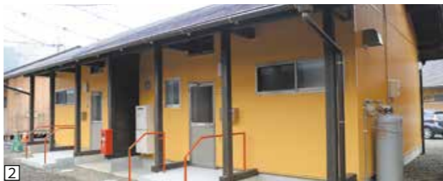
② 昭和地区美袋で令和 2 年 5 月から整備が進められた復興住宅。令和 3 年 7 月までに全 13 棟が完成した
